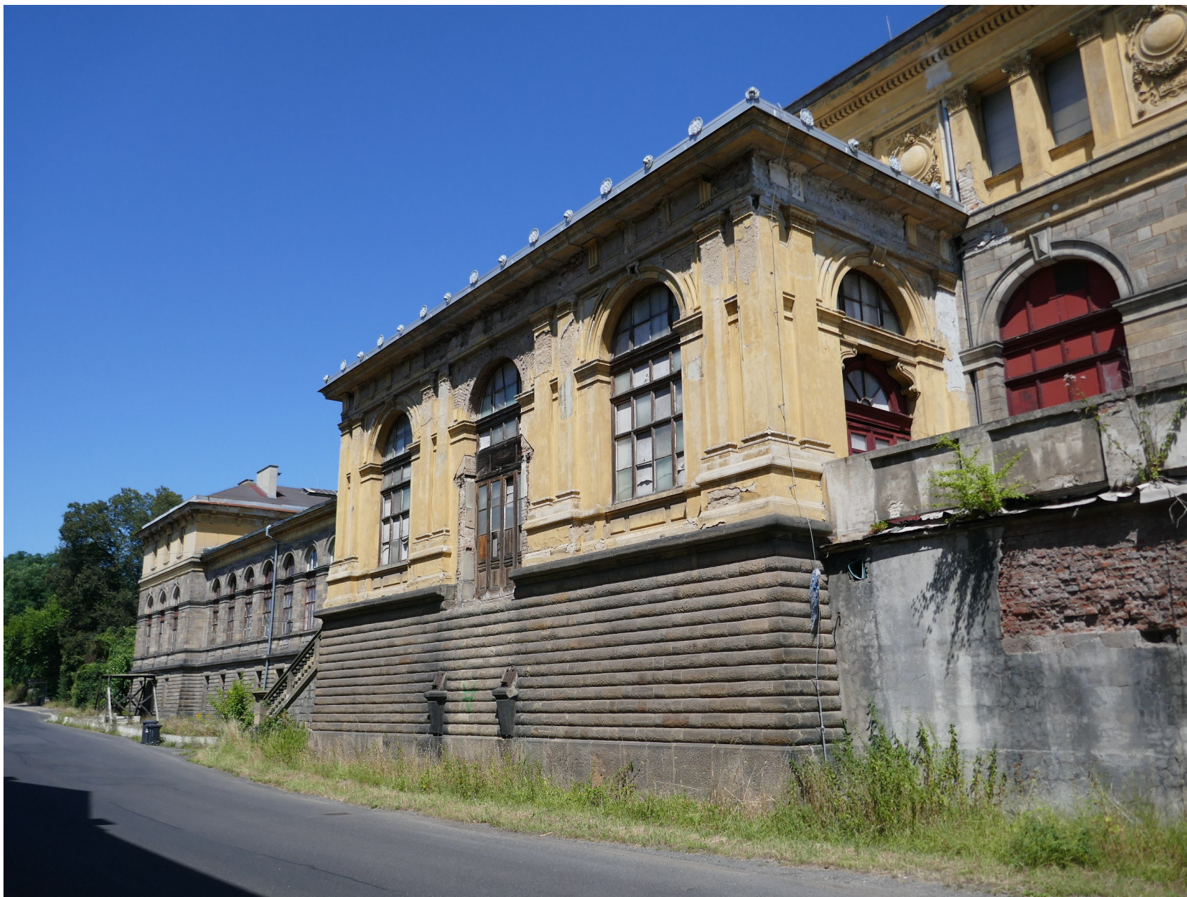
Čelní fasáda, objekt F. Foto: autoři SHP, 2024.
