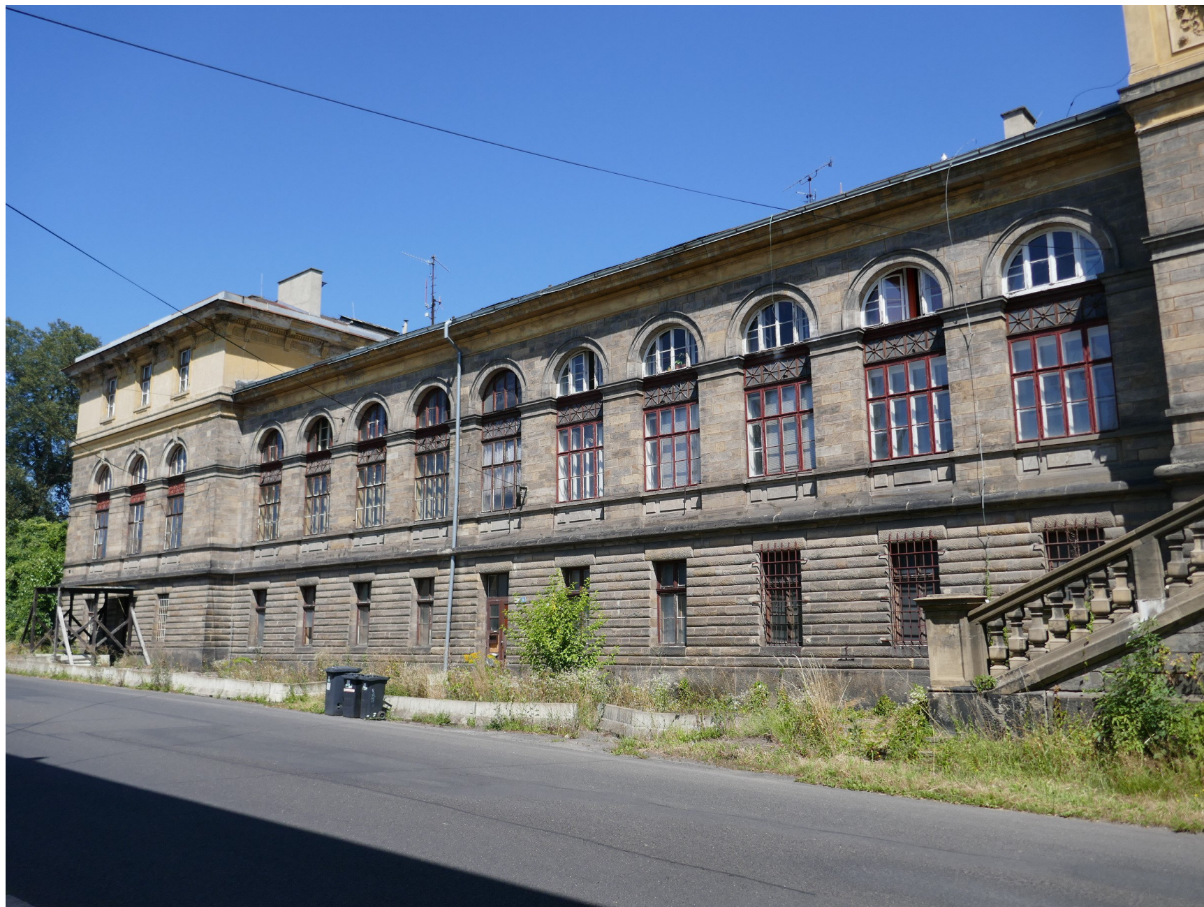
Celek, čelní fasáda. Objekt A a B. Foto: autoři SHP, 2024.
