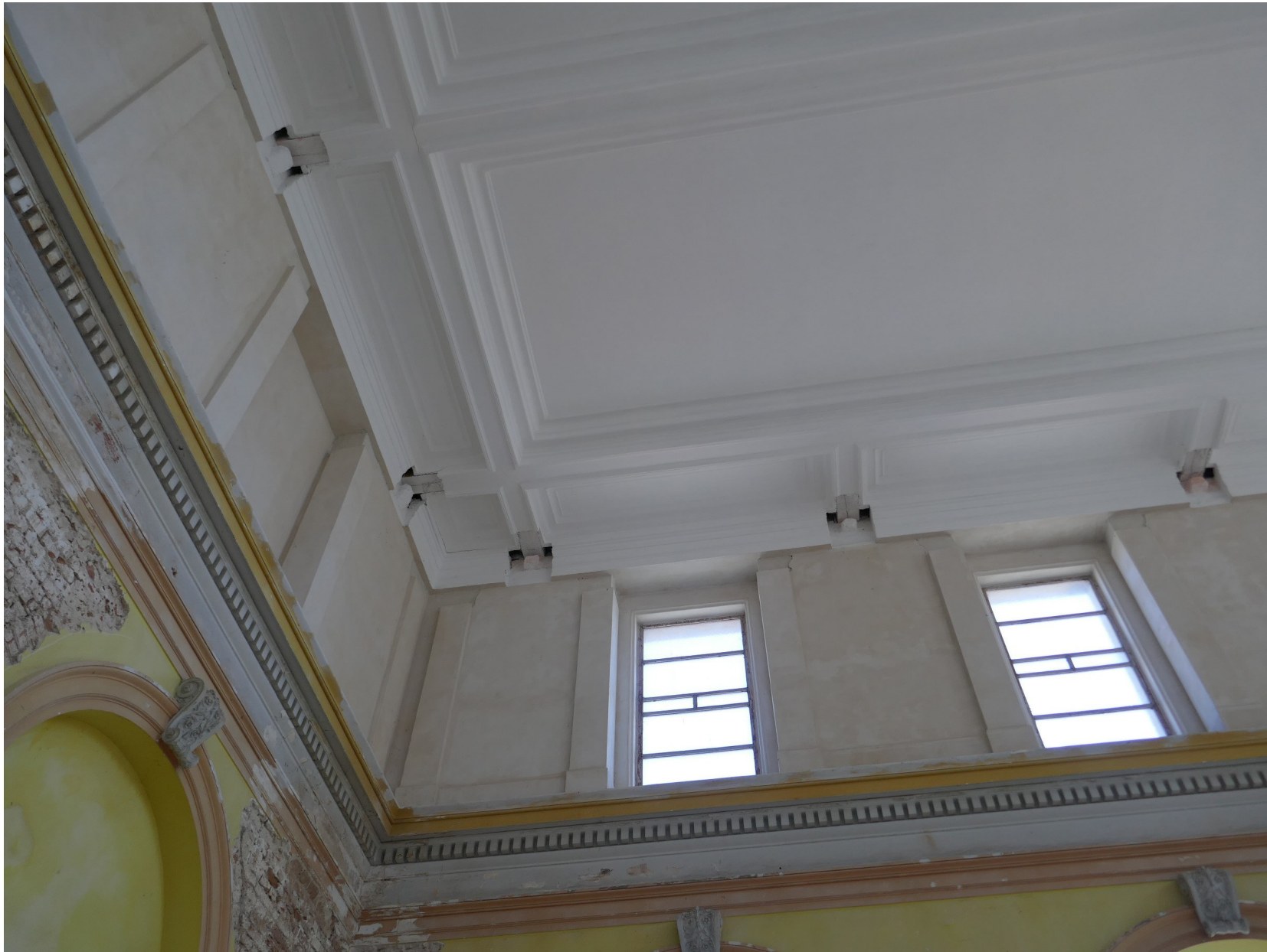
Objekt E strop a členění vnitřních stěn. Foto: autoři SHP, 2024.
